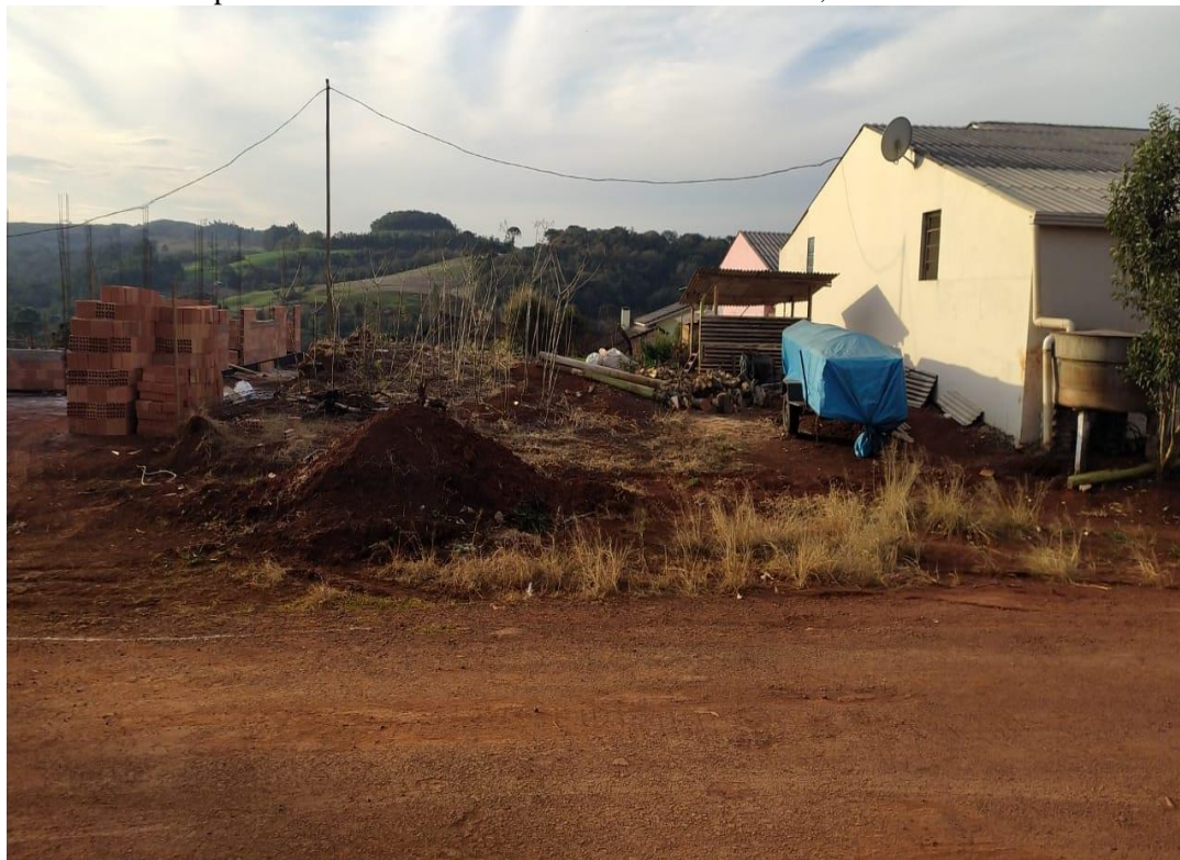
Foto 01 – Vista parcial do imóvel terreno urbano medindo 350.,04 m 2
