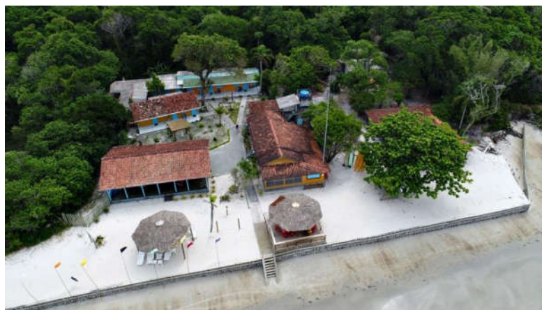
Imagem aérea por drone com as edificações existentes no lote.
